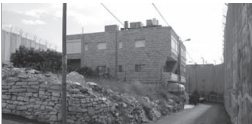
De muur in Bethlehem, niets ontziend gebouwd om drie kanten van het huis van de familie Anastas
